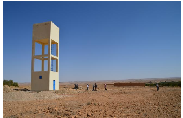
Fig 2 : Le château d'eau de (50m 3 ) de TENT
