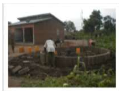
Construction de la « Paillotte » salle d'attente
